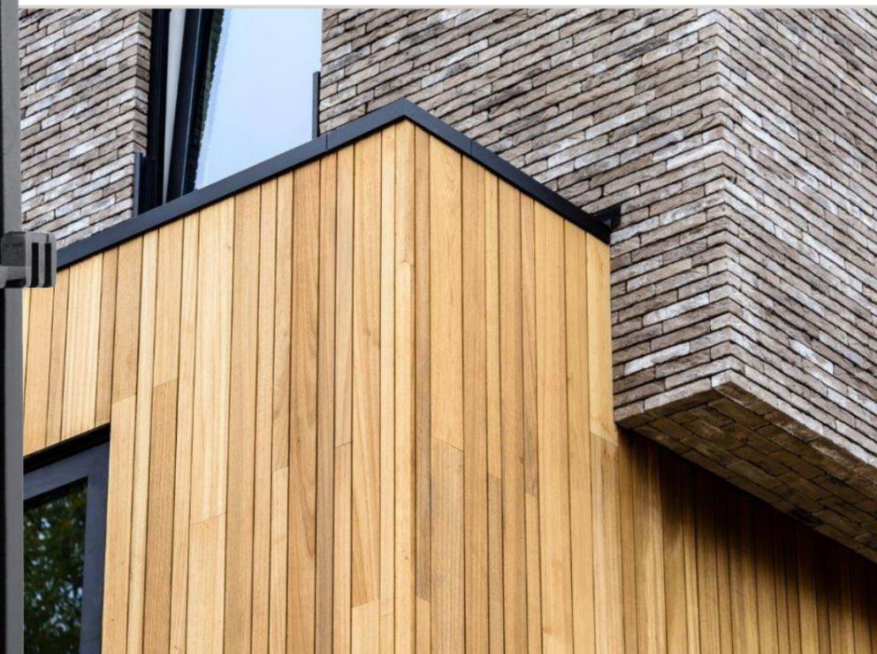
Techniclic®, DAS NEUE SYSTEM FÜR FASSADEN, WÄNDE UND DECKEN IN HOLZ MIT UNSICHTBARER BEFESTIGUNG
