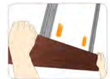
03 Montage des Holzpaneels
