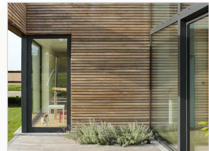
> Waagerechte Verlegung
