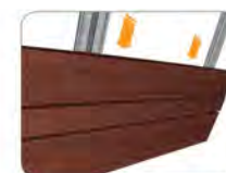
06 Suivre ce processus pour assembler le reste du bardage
