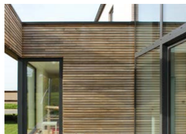
Instalare orizontală
